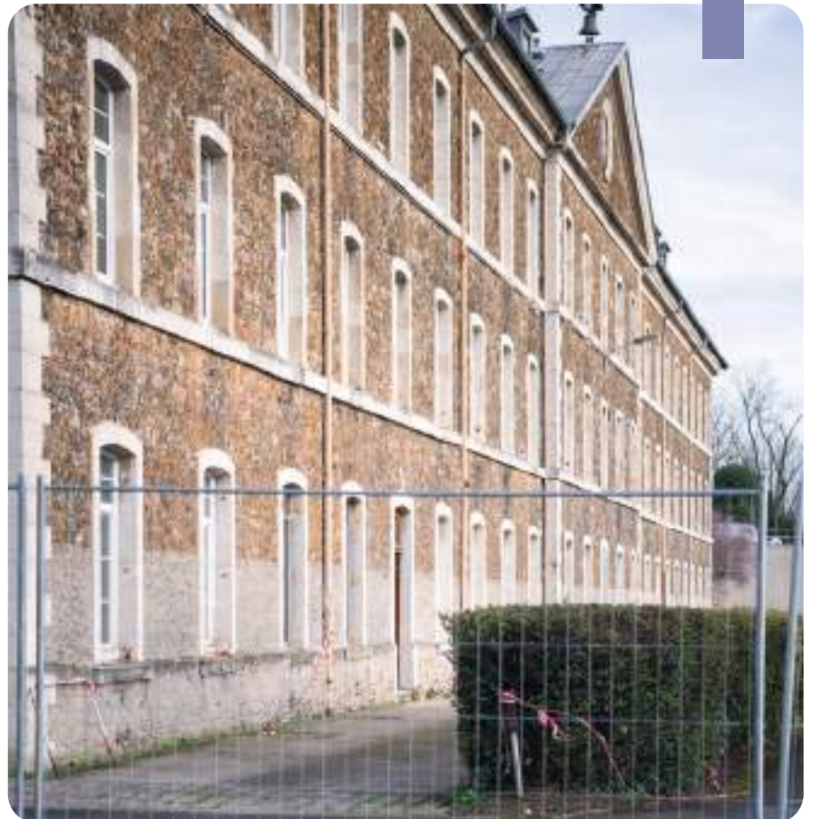
1 er mars 2024, Fort d'Ivry-sur-Seine (Val-de-Marne) Extérieur du bâtiment Vie en cours de rénovation © Malo Harmant/ECPAD/Défense
