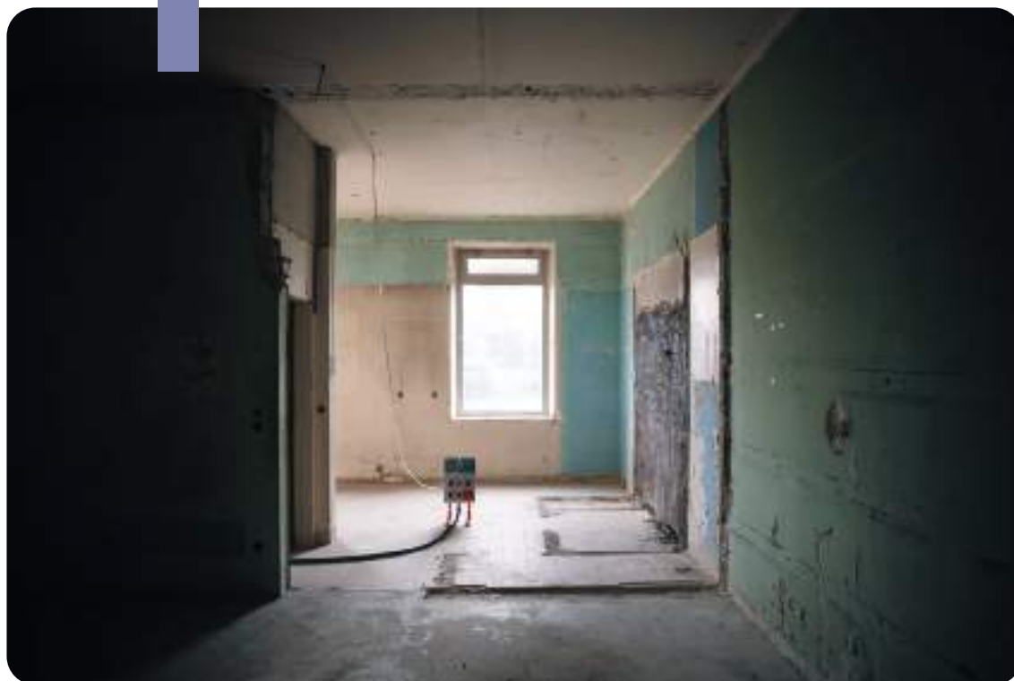
1 er mars 2024, Fort d'Ivry-sur-Seine (Val-de-Marne) Intérieur du bâtiment Vie en cours de rénovation © Malo Harmant/ECPAD/Défense
